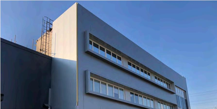
Grazie alla perfetta configurazione del giunto, oltre a rendere piacevole ed uniforme la superficie dell'involucro edile, il pannello Isolpack è in grado di abbattere considerevolmente i ponti termici che, come è noto, sono causa di dispersione energetica e formazione di condensa.
