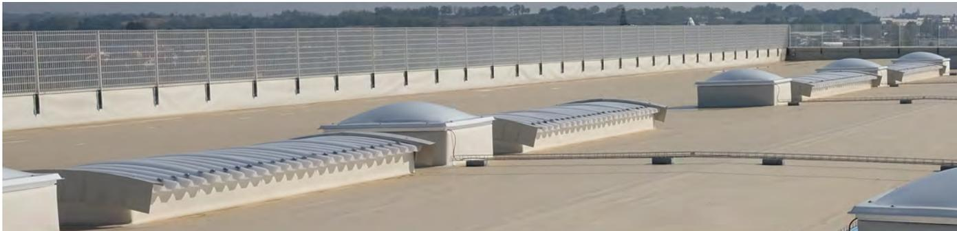
Le coperture **DECK** sono prodotte in continuo con un supporto metallico in acciaio zincato e un supporto all'impermeabilizzazione in cartongfello bitumato sul quale potranno essere applicate le diverse guaine impermeabilizzanti e strati per la protezione della copertura.
